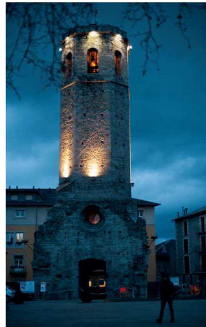
Puigcerdà to jedno z wielu katalońskich miasteczek ze średniowiecznym rodowodem. Tamte czasy pamięta między innymi Torre del Campanar – wieża parafialnego kościoła z XII wieku, który został zniszczony w 1936 roku
